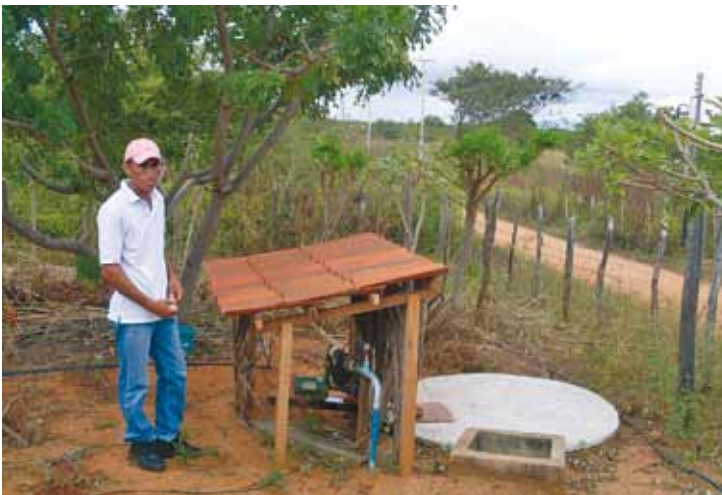
Figura 4: Tanque de reuso com eletrobomba
